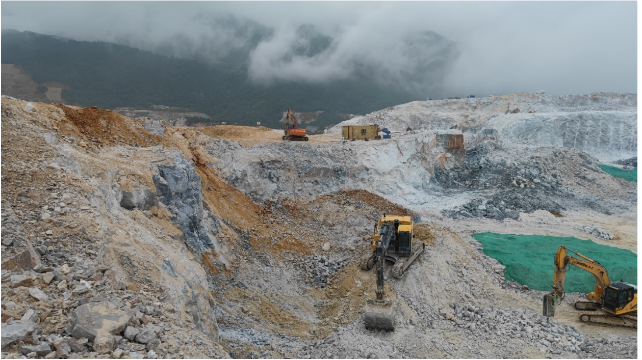
照片1 露天采场东北部开采现状
