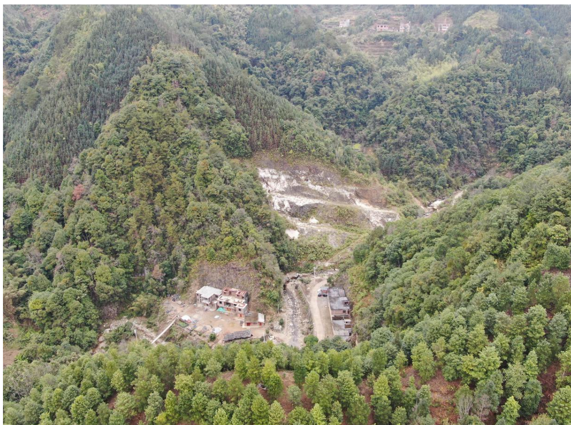
照片 1 矿山工业场地及民采坑 CK1 现状（拍摄方向 8^{\circ} ）
