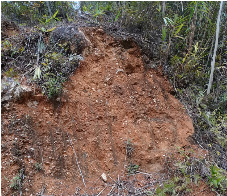
照片 2-2-2 矿区土壤结构剖面（位置：矿区农村道路边坡）
