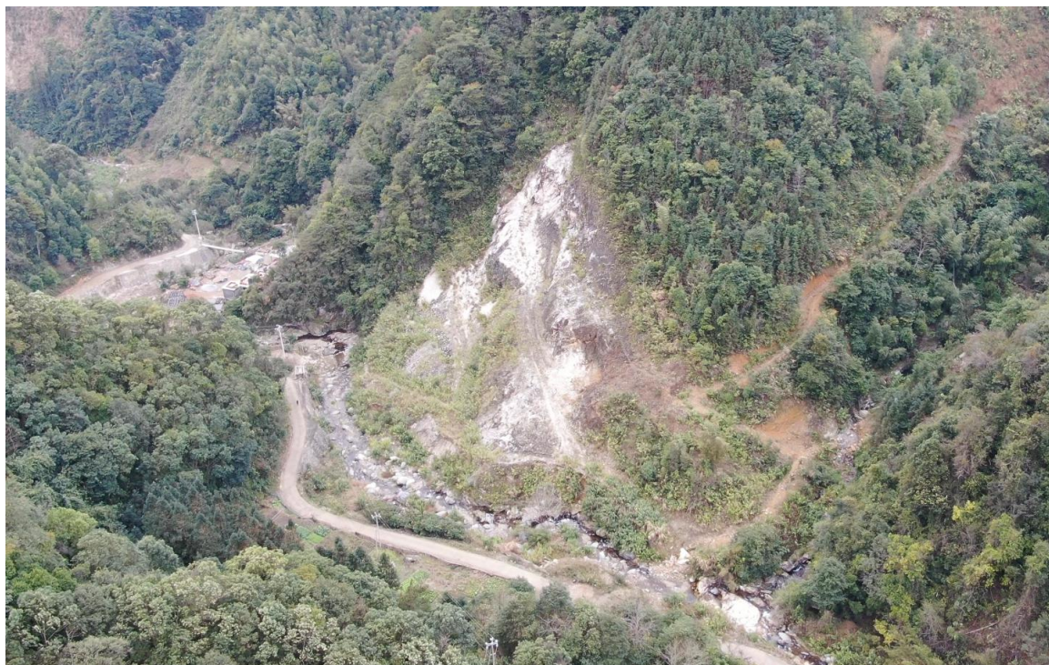
照片 5 民采坑 CK1（拍摄方向 220°）
