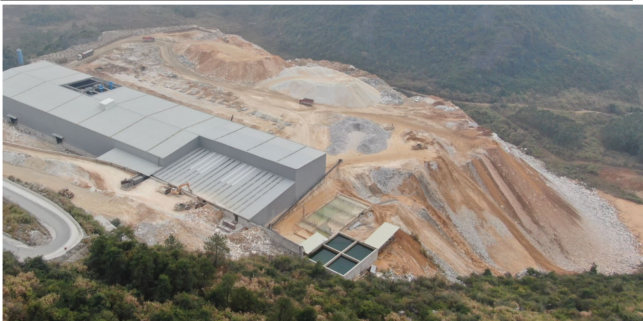
照片 5-2-1 黄沙庙 2 号排废区堆放的废渣土
