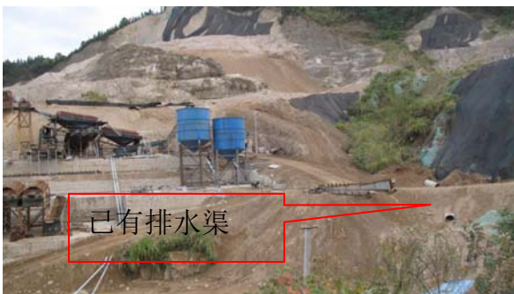
照片 7 已有排水渠中段（道路拍摄，镜像 240°）
