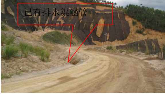
照片 9 矿山运输道路（平台拍摄，镜像 20°）
