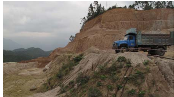
照片 4 旧沉砂池（工业广场拍摄，镜像 190°）
