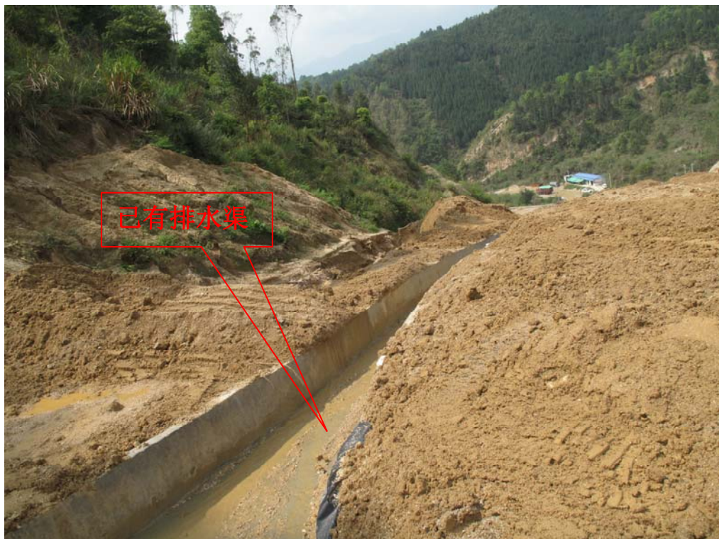
照片 6 已有排水渠起点
