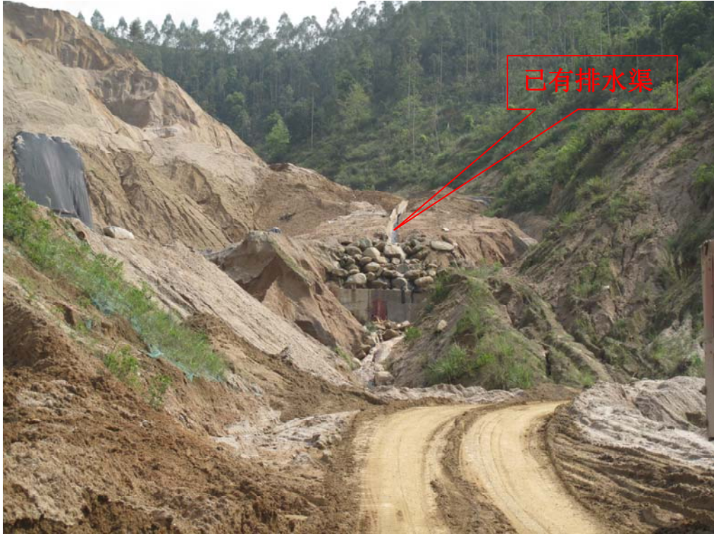
照片 7 已有排水渠中段
