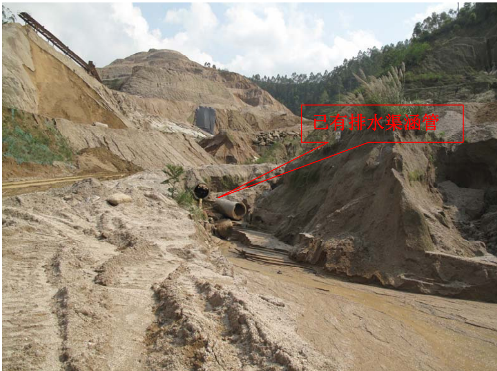
照片 8 已有排水渠终点涵管
