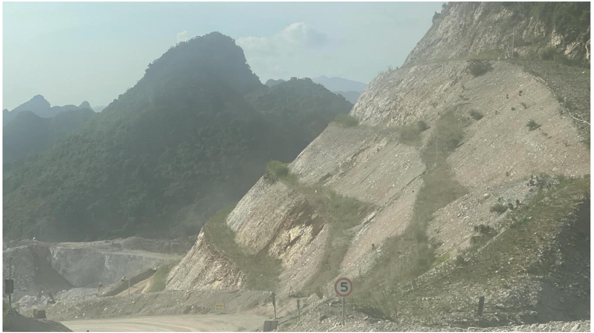
照片 3 北部采场终了边坡覆绿与平台土地复垦情况（镜像 330°）
