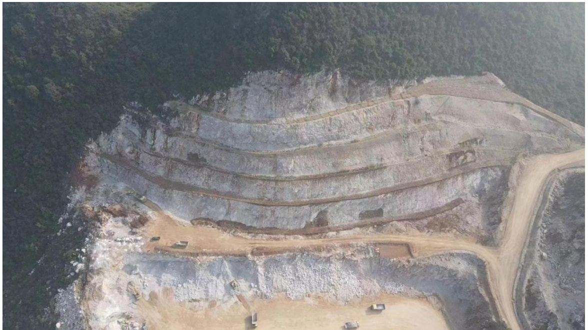
照片 4 北部采场终了边坡正面照（镜像 85°）
