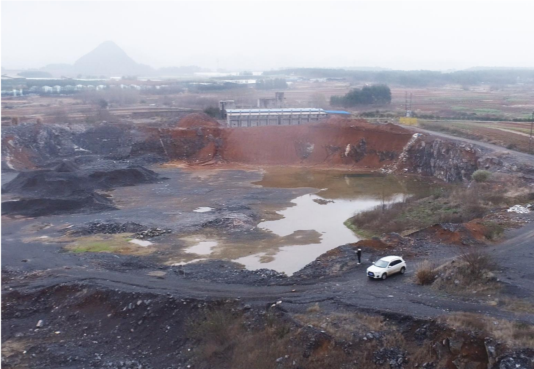
照片 3 矿山底部平台凹陷采坑现状
