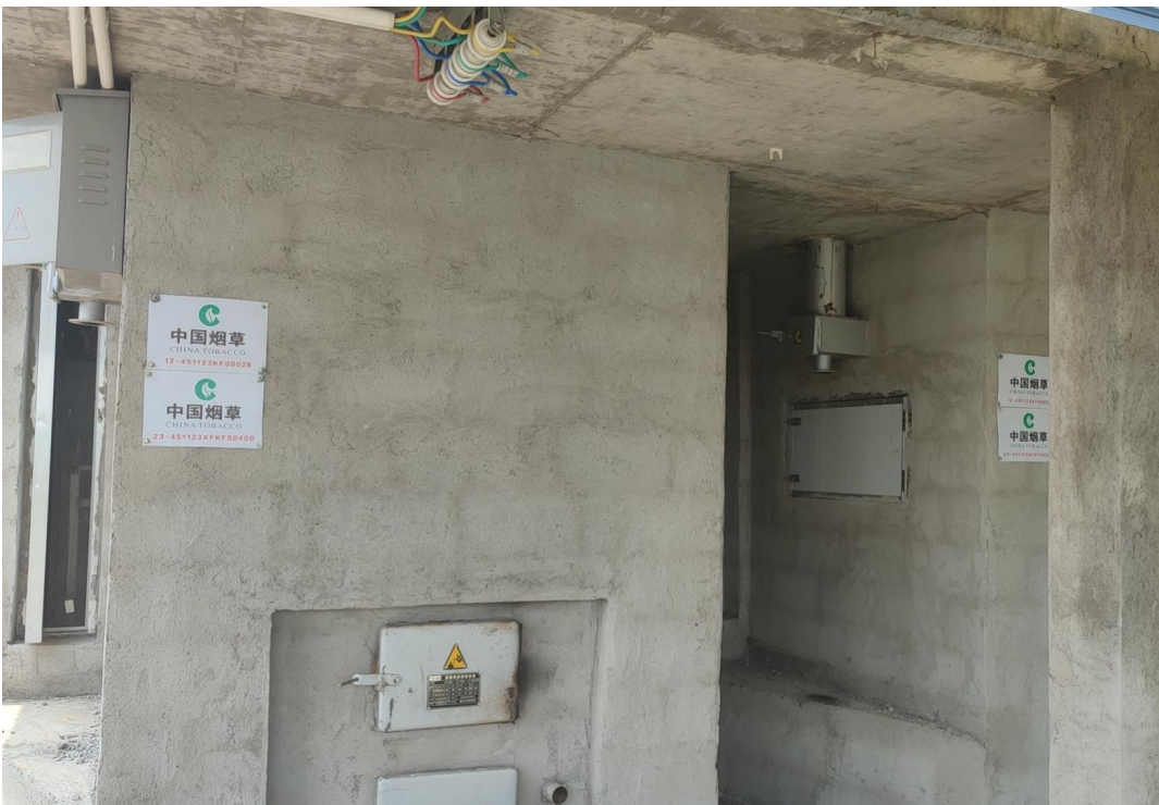
照片 8 矿区南东侧办公生活区现状
