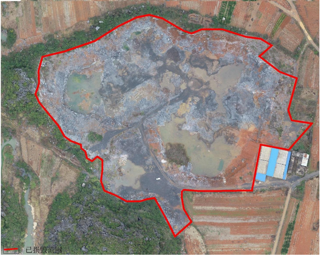
照片 1 矿山现状全景图
