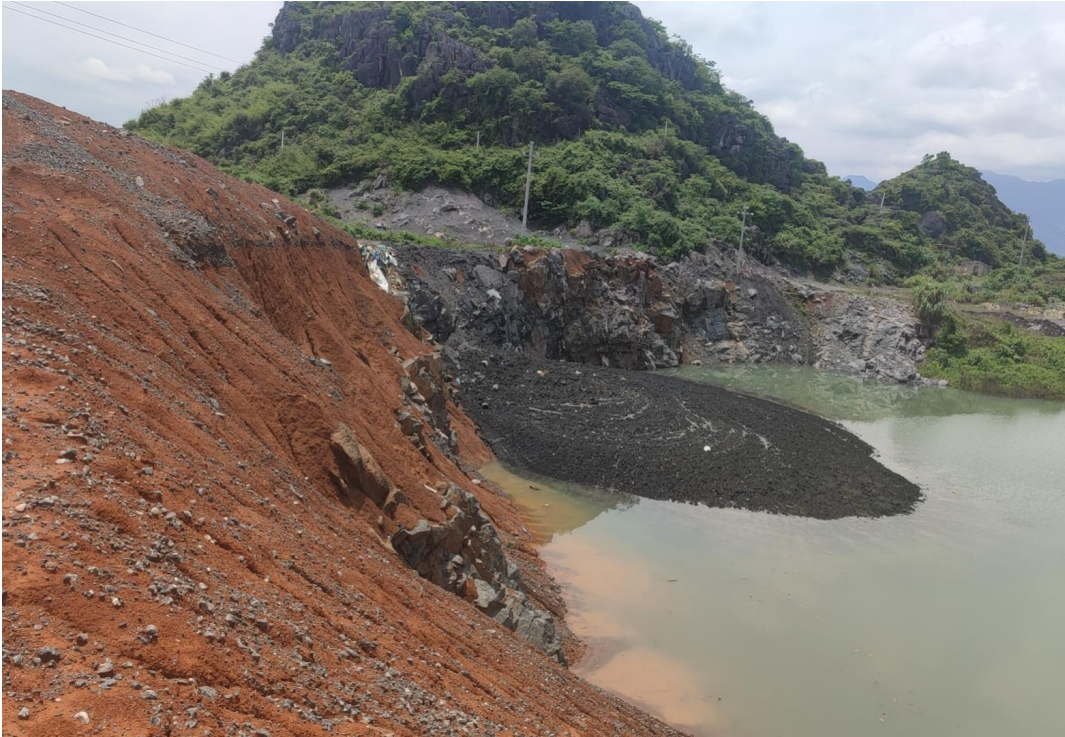
照片 7 矿山底部平台凹陷采坑现状
