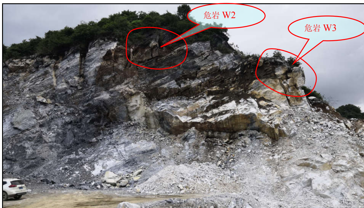
照片 3-2-2 4#露天采场边坡危岩 W2、W3
