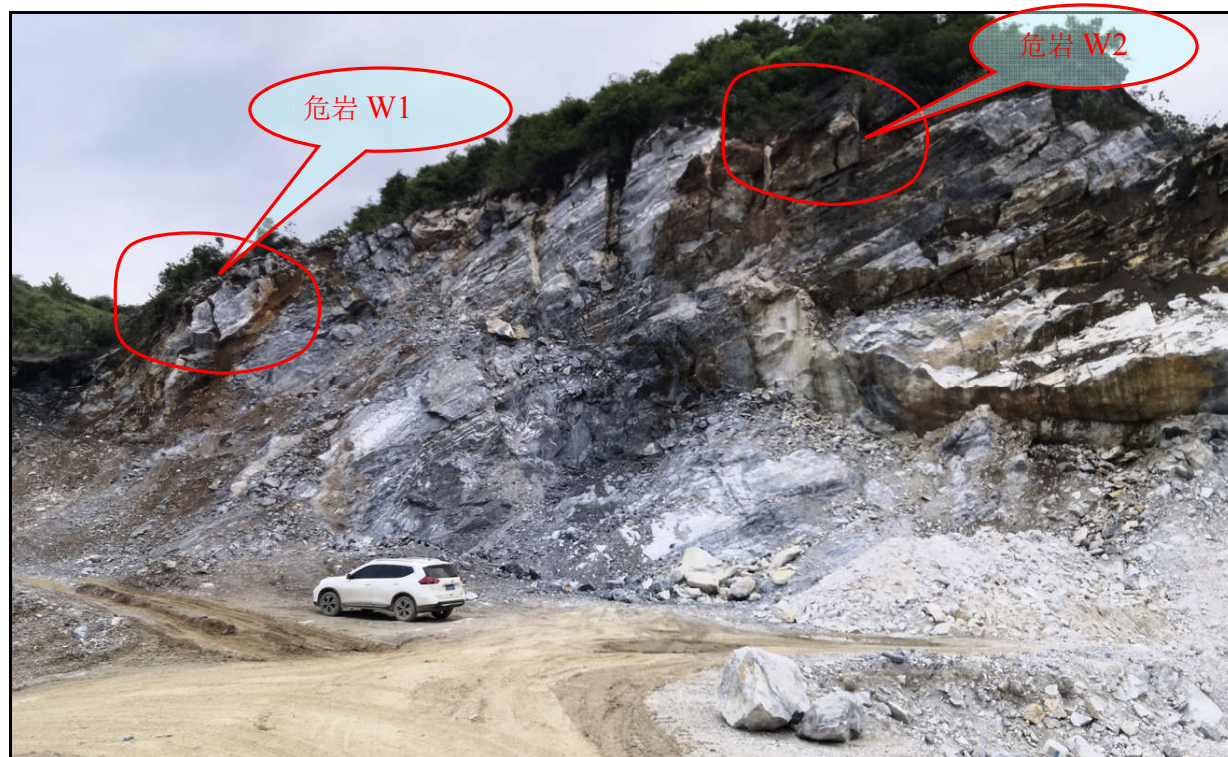
照片 3-2-1 4#露天采场边坡危岩 W1、W2
