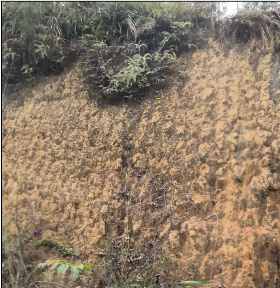
照片 2-2-2 矿区土壤结构剖面（位置：2#民采区边坡）
