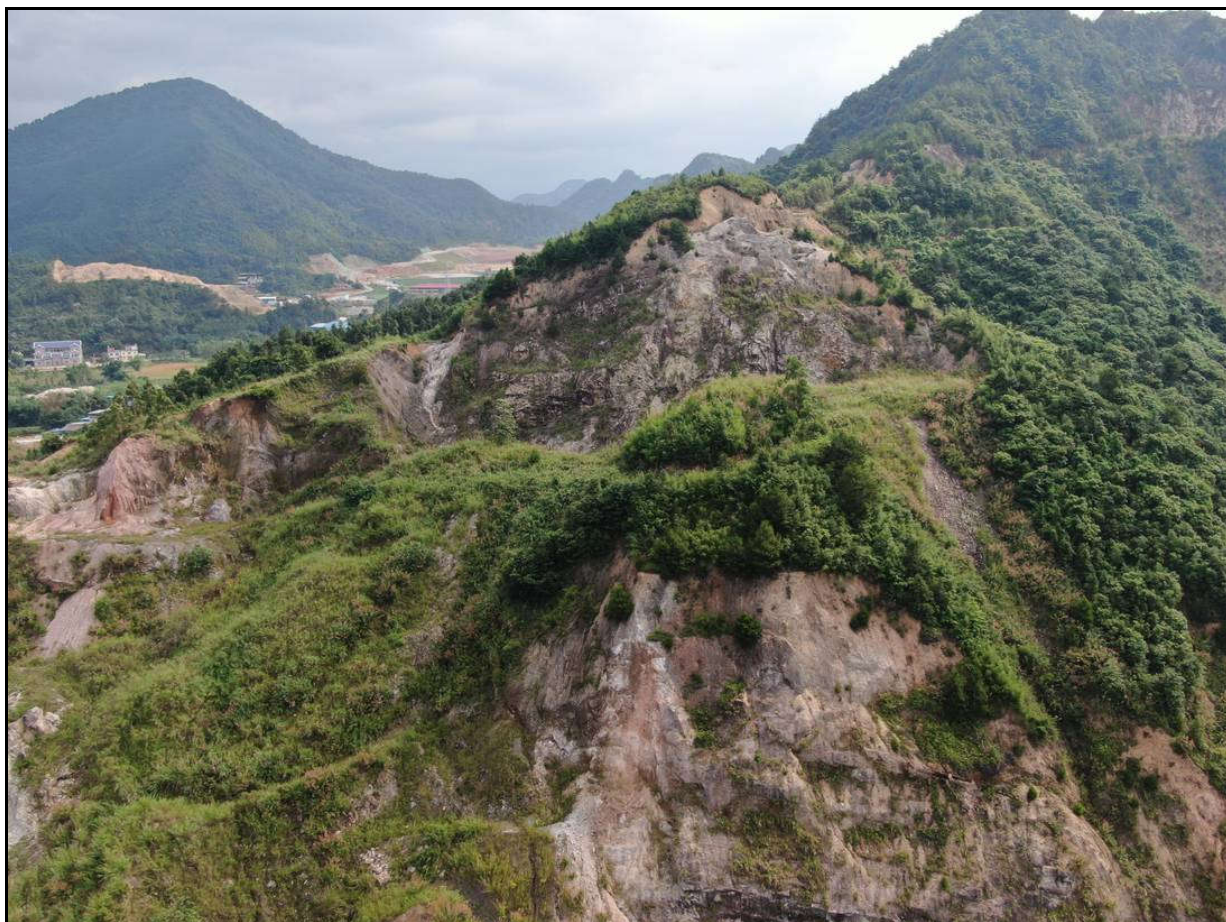
照片 3 1#民采区现状（拍摄方向 4°）
